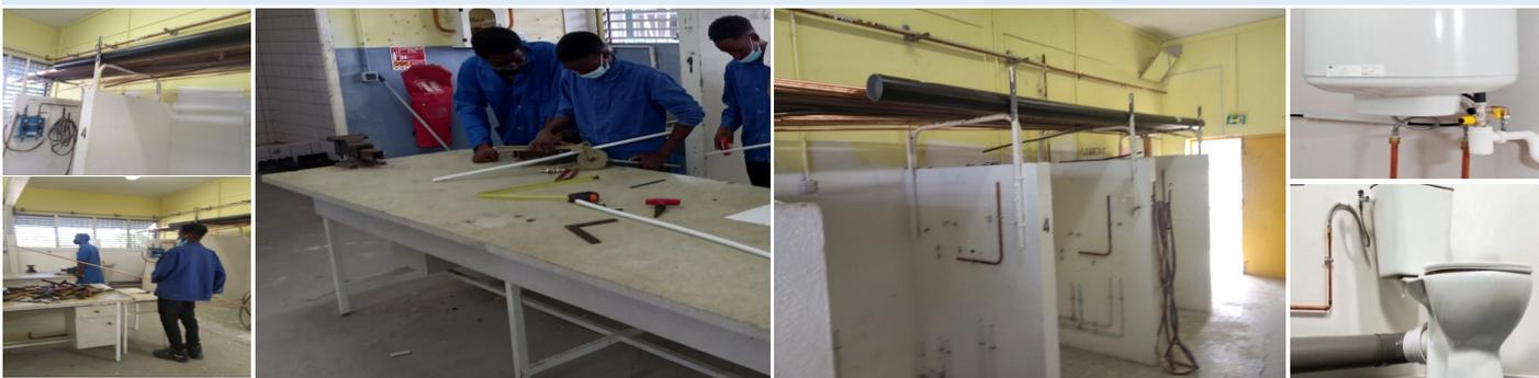
Le cuivre ou le multicouche travaillé pour être monté sur les murs dans des box.
