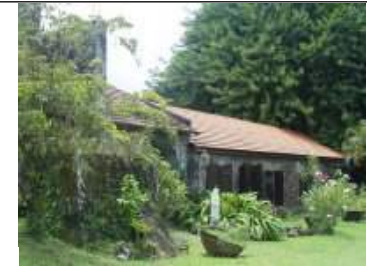
Bâtiment du moulin (13), sucrerie (14)
