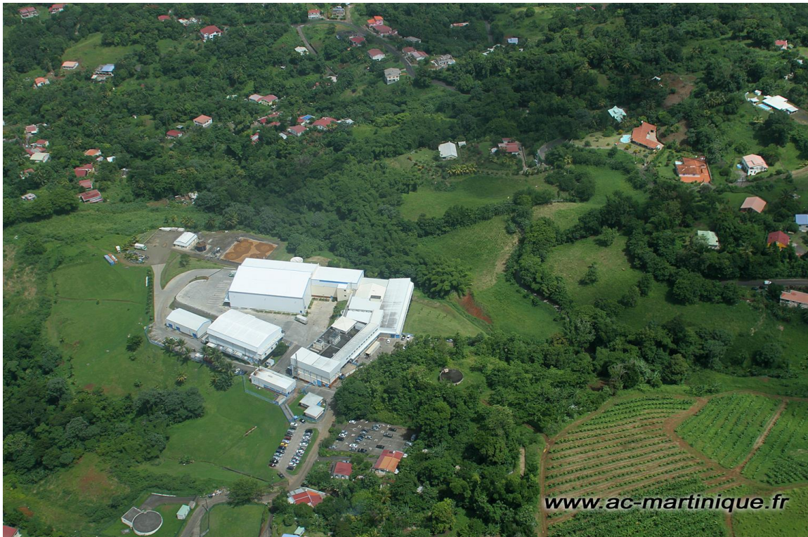
Doc.6 : Photo de l'usine SNYL le Vert Pré (source : http://albums.ac-martinique.fr/ ) Vue d'ensemble et zoom sur les bassins de décantation des effluents industriels
