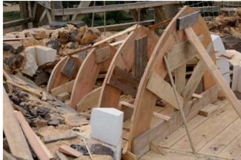
Les maçons ont posé et réglé les 4 vaux : cintres en bois reprenant la forme de la voûte. Sur ces vaux, ils vont fixer des lattes de bois. Cet ensemble formera un coffrage permettant de soutenir les maçonneries de la voûte.
