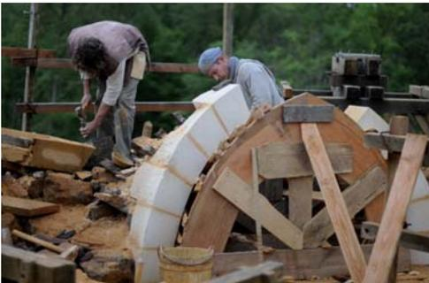
Il reste à poser les 2 contre-clés et la clé de l'arc ainsi que les dalles qui vont fermer et bloquer définitivement la voûte.
