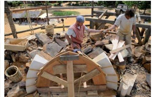
Les 4 premiers voussoirs en calcaire, de chaque côté de l'arc brisé, sont maçonnés. Les maçons placent au fur et à mesure les lattes de chêne, puis les dalles de grès ferrugineux sur champ. Le réglage s'effectue à la règle.
