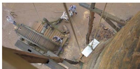
Le dernier culot est hissé à l'aide de la cage à écureuil à 15 m de hauteur. Puis, il est déplacé en haut de la tour à l'aide de roues. Cette opération est rendue délicate par le poids et la relative fragilité des éléments floraux sculptés sur la face avant du culot. Un culot pèse environ 150 kg.
