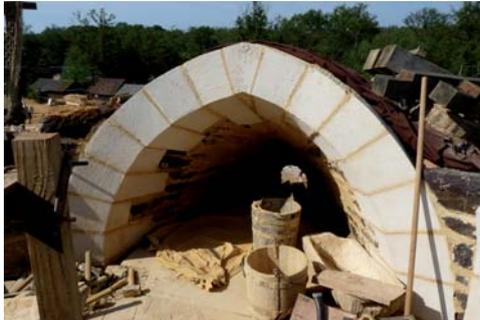
L'arc brisé et la voûte conique sont terminés ! Les maçons vont attaquer, en fin de semaine, la maçonnerie de la voûte de la 2ème fenêtre en lancette.
