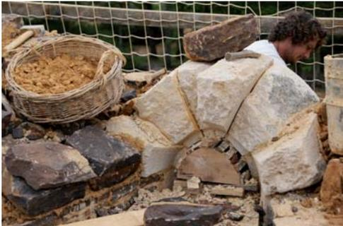
L'arc brisé donnant sur l'extérieur est terminé. Le coffrage soutient encore les voussoirs. Cet arc est couronné par une clé formée de 2 voussoirs.
