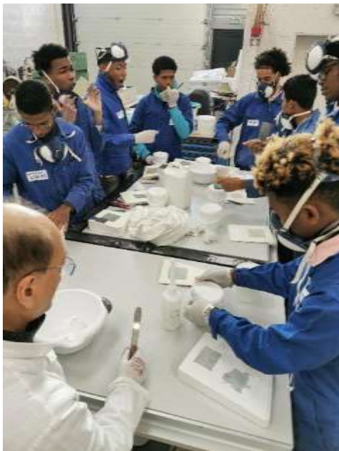
Formation à la réparation des surfaces antidérapantes
