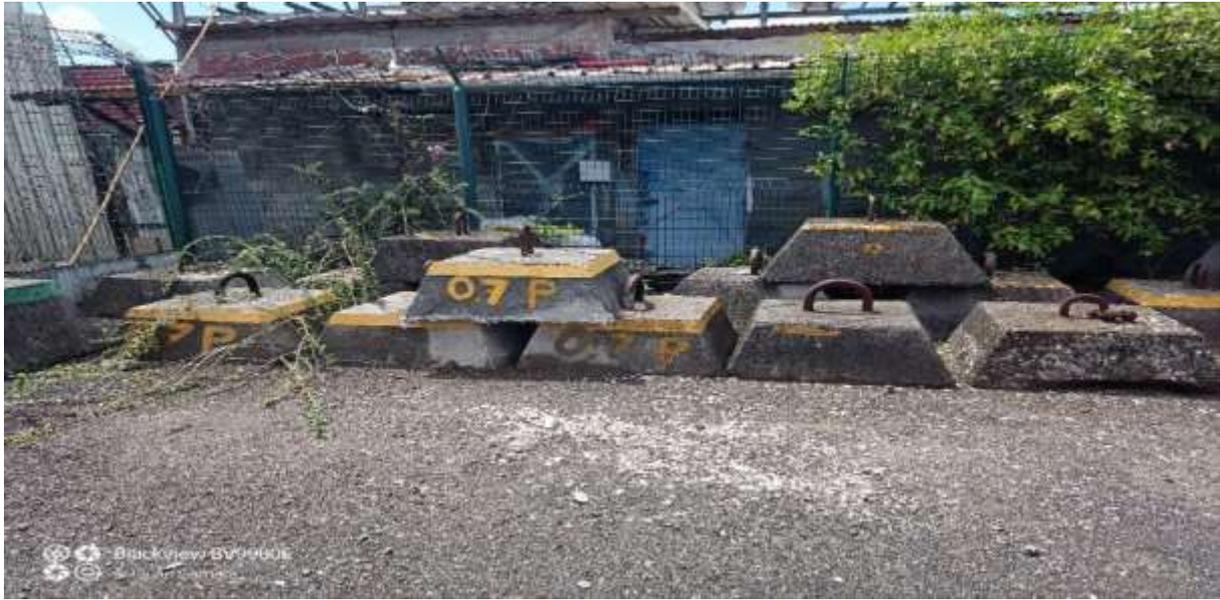
Corps morts pour le positionnement des balises en un point GPS déterminé
