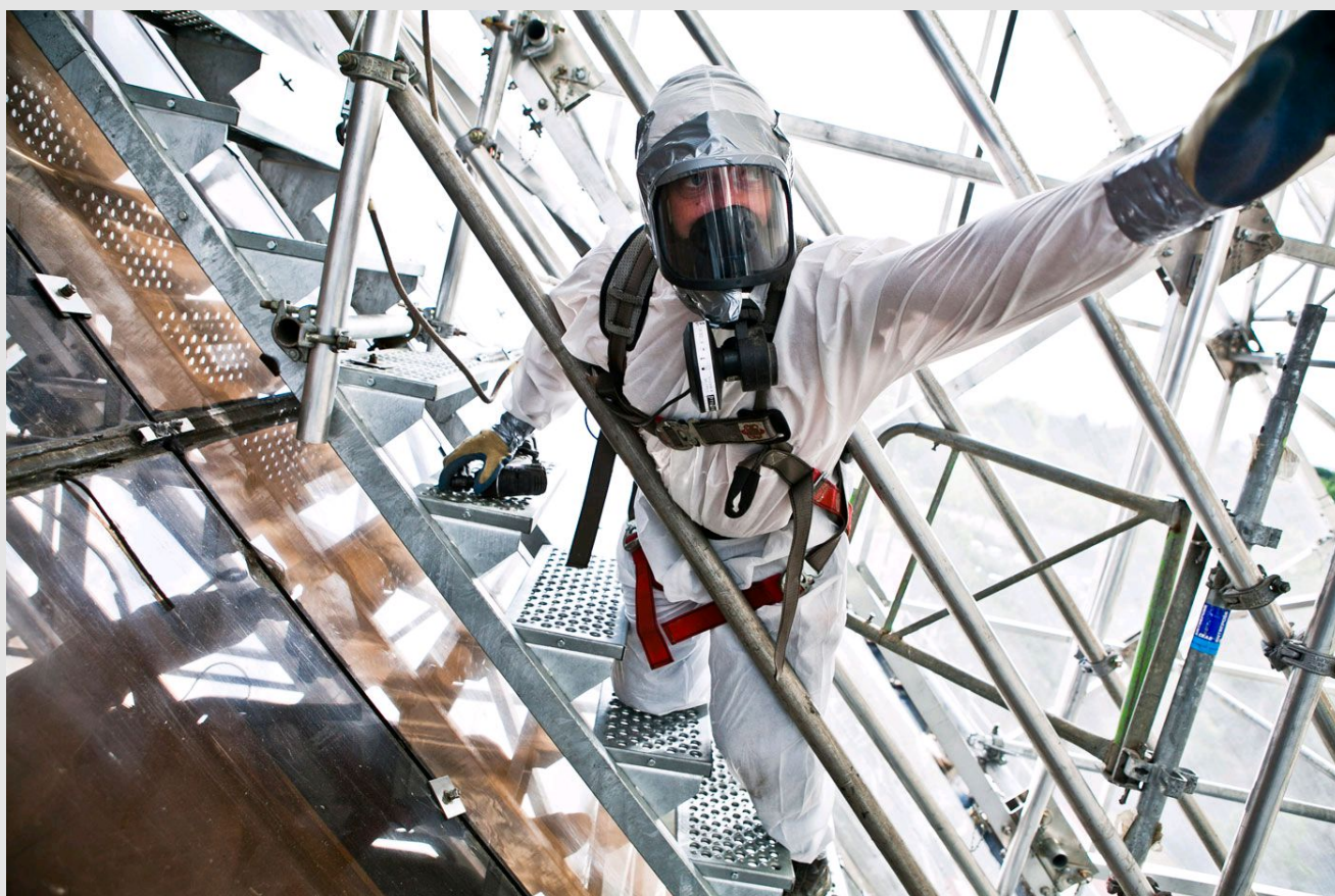
Opérateurs en combinaison de protection jetable, avec masque à ventilation assistée, équipés d'un harnais sur un chantier de désamiantage
