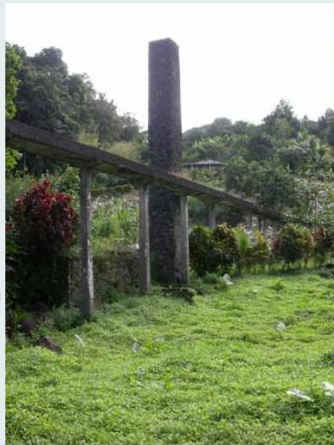
Vue d'ensemble : aqueduc, cheminée.
