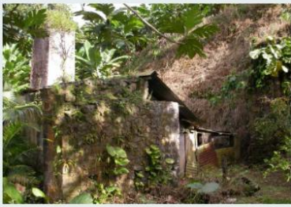
Vue d'ensemble : cheminée et ancien mur.
