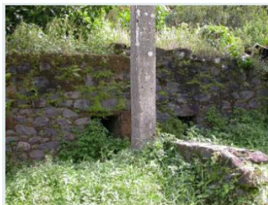
Vue d'ensemble : fourneaux.
