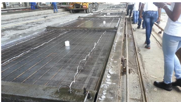
Préfabrication d'une prédalle
