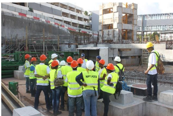
Visite du chantier
