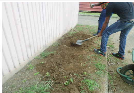
Décaissement de la terre argileuse sur environ 20 cm sur toute la longueur
